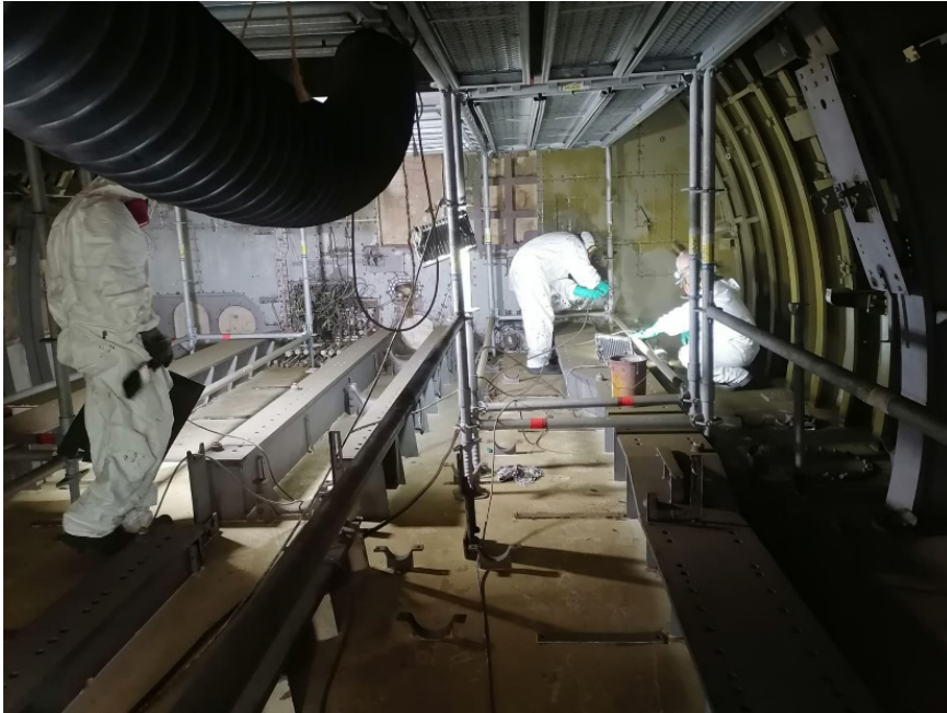
Trabajos de pintura y acondicionamiento de las secciones interiores en el B.A.P. Antofagasta .
