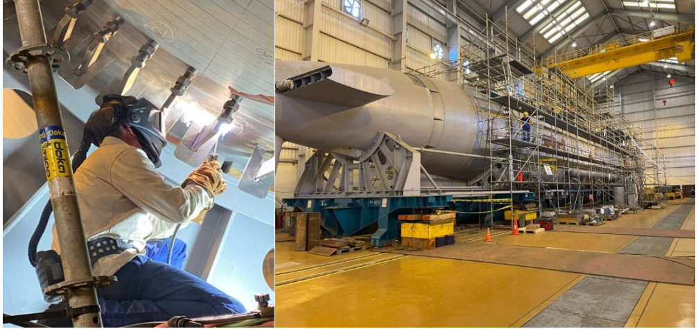
Soldadura de casco el B.A.P. Chipana y submarino completamente soldado.
