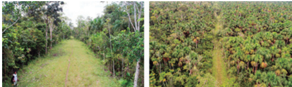
Figura 3. Estado actual de la carretera afirmada Puerto Arica – Flor de Agosto.
