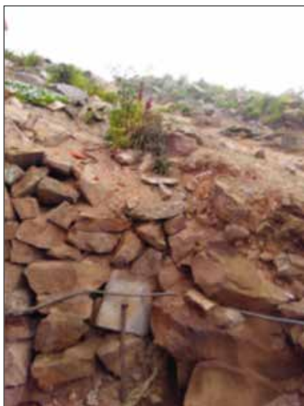
Piedra reutilizada como muro de contención.
