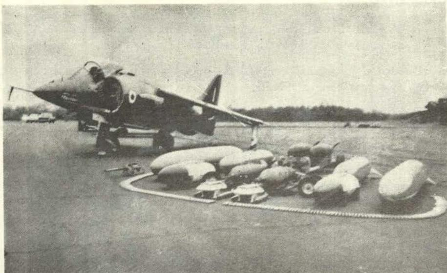
Presentación de las cargas que puede transportar simultáneamente (2,270 Kg. máximo): depósitos largables, bombas de 453 Kg., ametralladoras ADEN de 30 mm. misiles y lanza-cohetes SNEB
