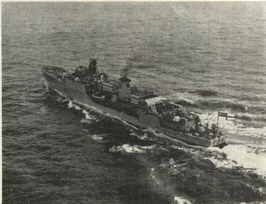
En la fotografía se pueden apreciar las elegantes líneas del "Exmouth" navegando a velocidad. Además de ser uno de los barcos de guerra más rápidos de la actualidad, la fragata está completamente equipada para navegar en silencio absoluto. Las turbinas de gas no producen ruidos de baja frecuencia, fácilmente detectables, sino un zumbido de alta frecuencia que puede aislarse fácilmente.
