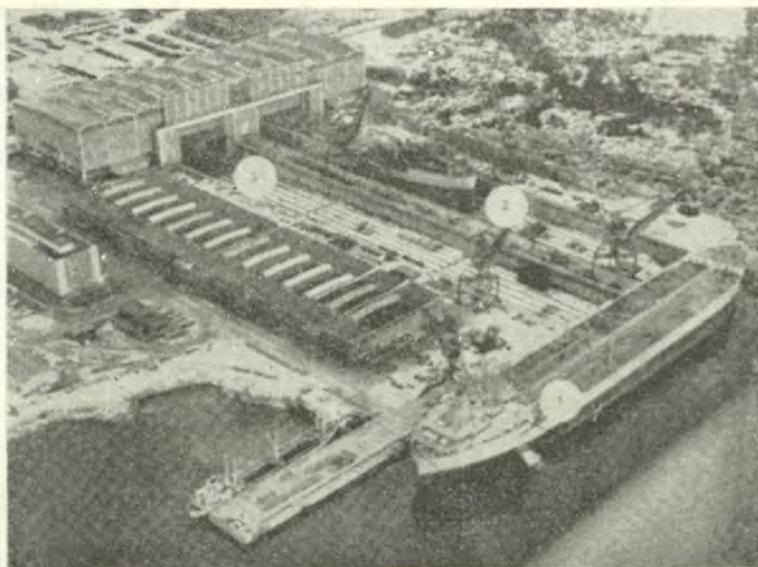
Fig. 6.—El primero, segundo y tercero de los doce buques estanques de 70,000 toneladas que se construyen en el Astillero de Arendal.
