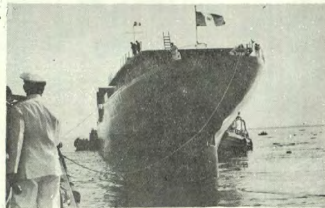
Ya en el agua, el B.A.P. "Lobitos" se acerca al flamante muelle de montaje, donde se finalizará las obras de acabado.
