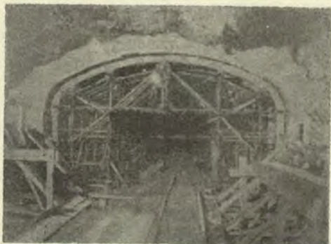
Alveolo subterráneo. Oficinas de 6 metros de ancho en proceso de descimbramiento.
